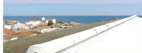
Atap Asbes & Kayu
